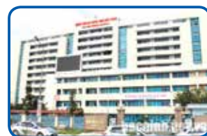
Bệnh viện Đa khoa tỉnh Bắc Ninh
